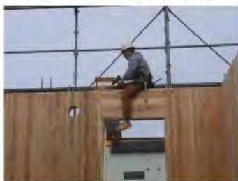
長尺スクリー施工状況(壁-垂壁)
