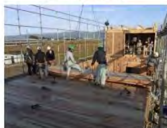
2階の床パネル敷き込み
