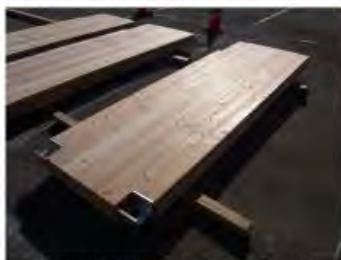
壁パネル(壁脚、壁頭金物取付)
