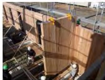
壁パネル建て込み
